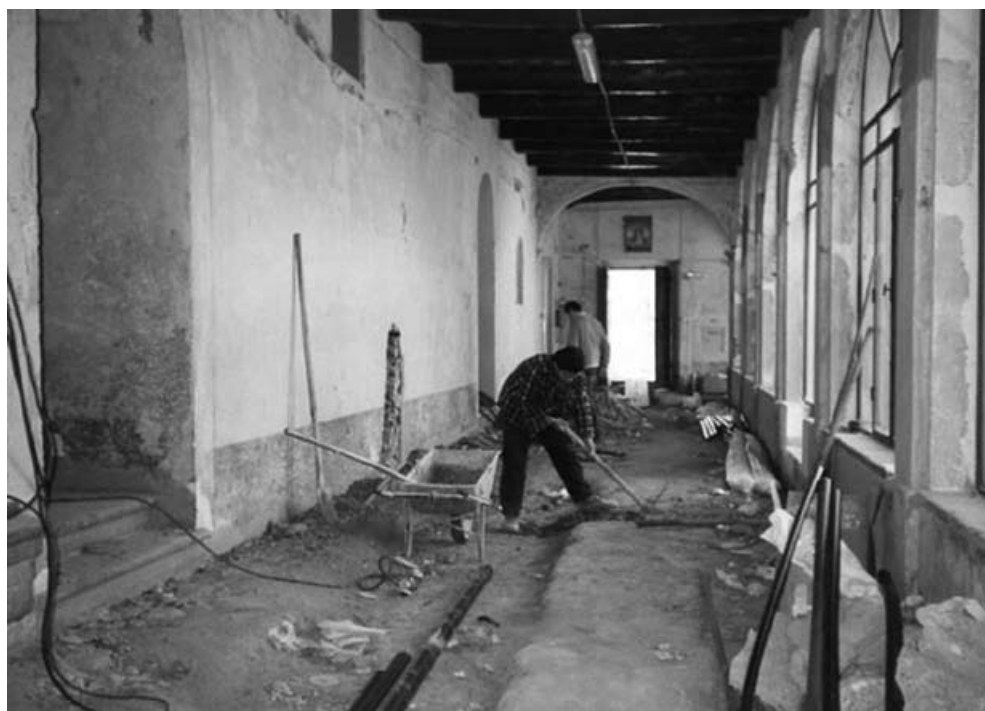
Anno 2001: Lavori nel corridoio.
