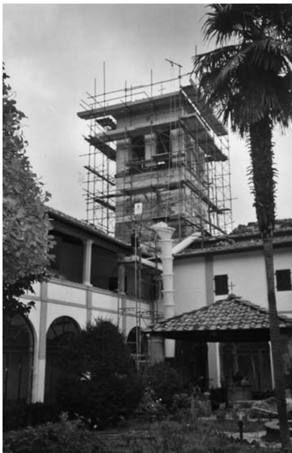
Lavori al campanile.
