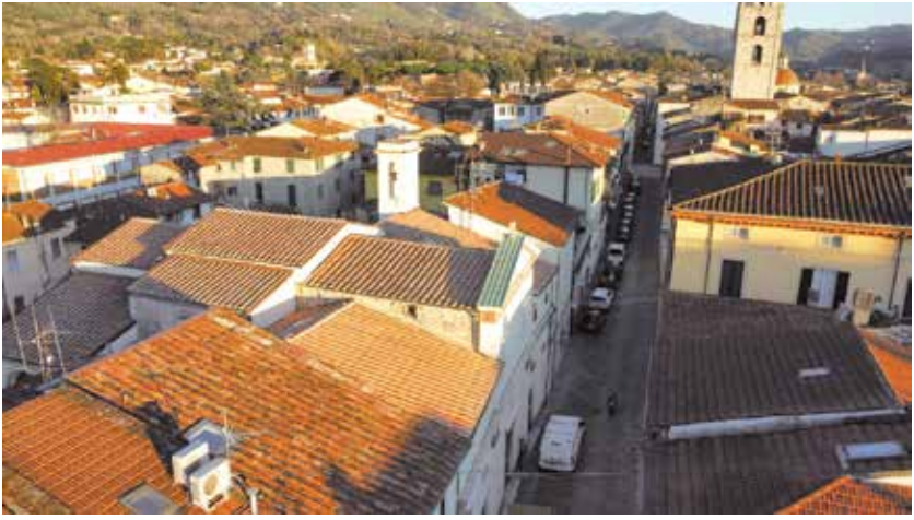
complesso storico della Misericordia visto dall'alto completamente risanato
